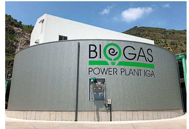
バイオガスパワープラント伊賀
